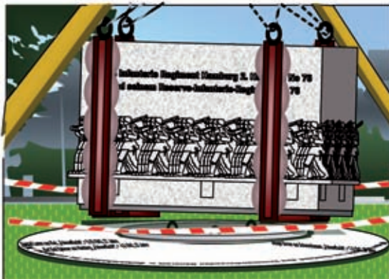
Wiederaufstellen des Denkmals auf das neue Fundament
