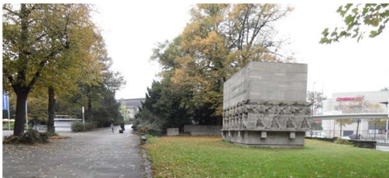
Bearbeitungsbereich vom Dammtordamm
