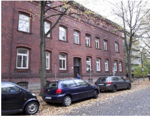
Ehemaliges Bekleidungsamt Sedanstraße, 2013, Foto: Sroka Architekten
