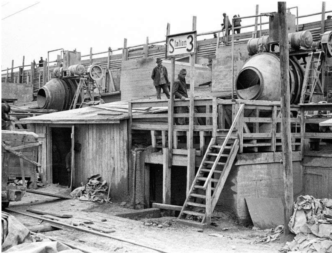
TAUSENDE ZWANGSARBEITER ERRICHTETEN VON 1943 BIS 1945 DEN U-BOOT-BUNKER VALENTIN. DAS FOTO ZEIGT DIE BETONMISCHER.
