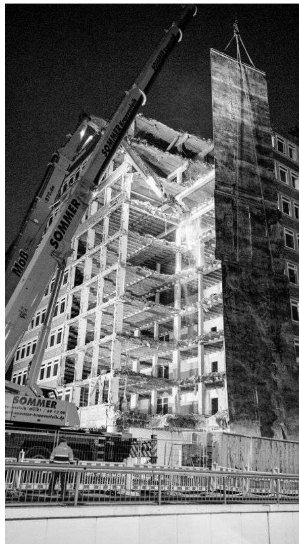
BEIM ABBRUCH DES KÜHNE + NAGEL-GEBÄUDES GEHT ES VORAN. IM MAI SOLL ES DEM ERDBODEN GLEICH GEMACHT SEIN.
