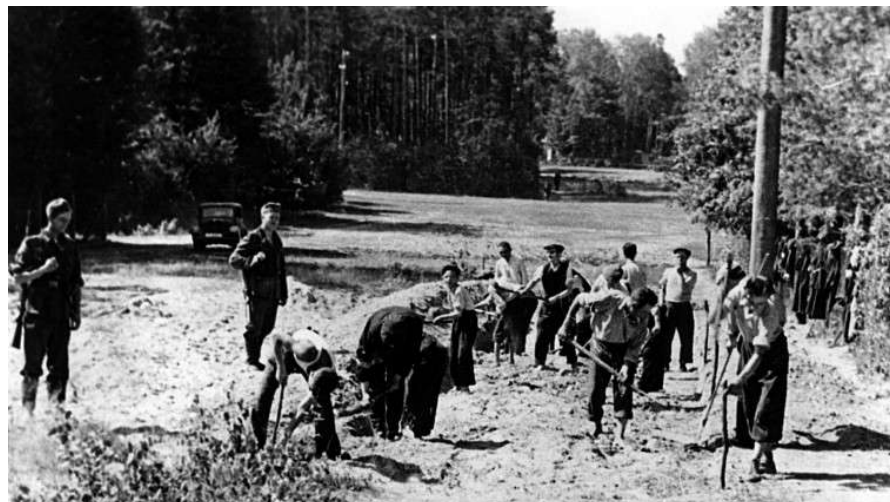
Während der Besetzung Polens durch die deutsche Wehrmacht mussten Juden - wie hier beim Straßenbau - Zwangsarbeit verrichten (undatierte Aufnahme). (picture alliance / dpa / Ullstein)
