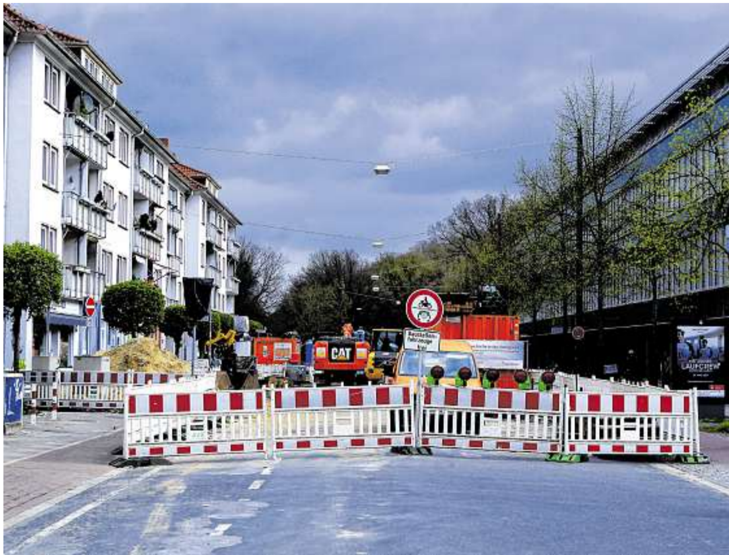
Hier ist Schluss: Der erste Bauabschnitt für die Kanalsanierung reicht von der Eickedorfer Straße bis etwa zur Buddestraße. FOTOS: FRANK THOMAS KOCH
