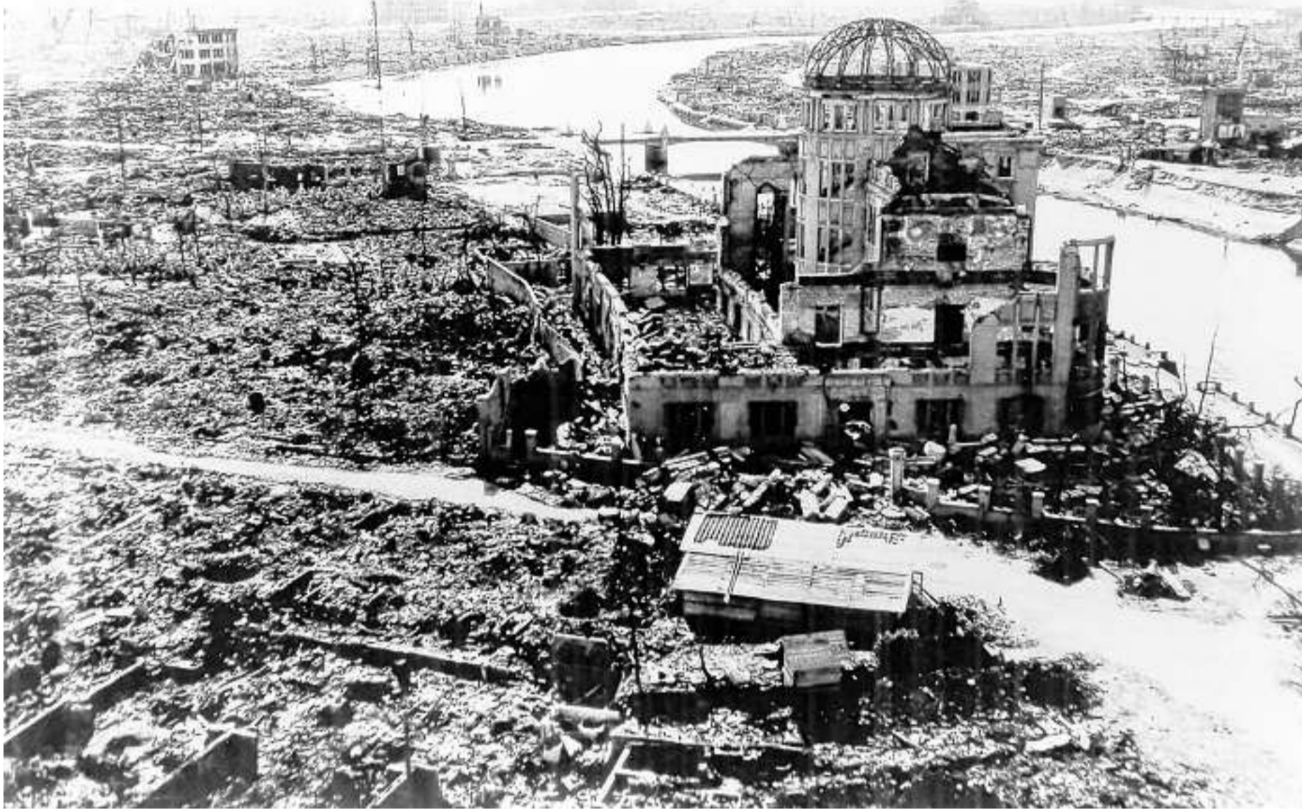
Dieses dreistöckige Ziegelgebäude war bis zum Morgen des 6. August 1945 eine Ausstellungshalle. Um 8.15 Uhr explodierte fast senkrecht über der Halle die erste in einem Krieg eingesetzte Atombombe. Alle, die sich in der Halle aufhielten, waren sofort tot. Am Ende stand nur noch der Kern des Gebäudes. FOTO: DPA
