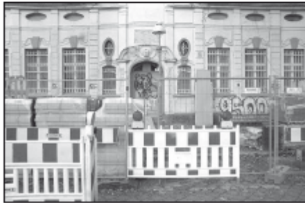
BAUSTELLE am historischen Ort. Foto: kappa-Photo
