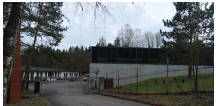
Hinter dem Neubau rechts war der Eingang in den Bunker, links vom Haupttor: das renovierte Unterakunftsgebäude.
