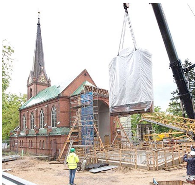
▲ Die Entfernung der Altarwand aus der Nikolauskirche in Hamburg-Alsterdorf.
