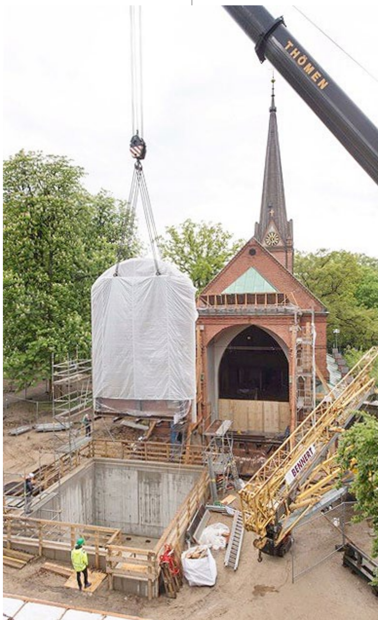
◀ Die gedrehte Altarwand wurde abgesenkt und lässt sich nun von oben betrachten.
