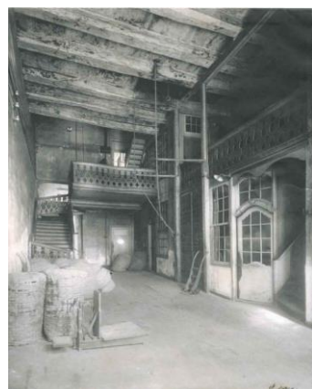
Die Diele mit dem Kontorfenster
